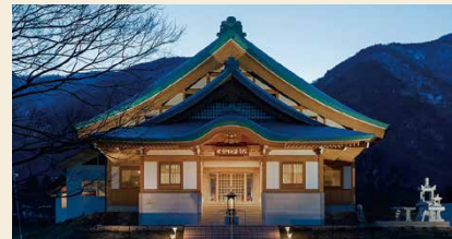
岐阜県養老郡 菩薩修行道場
